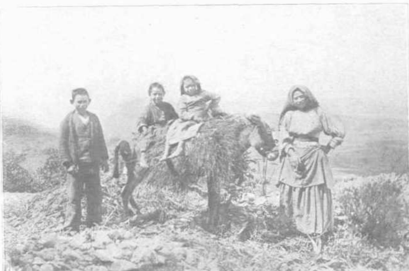
[Φωτ. Σπ. Καμινέση] ΑΠΟ ΤΟΝ ΚΑΜΠΟΝ
