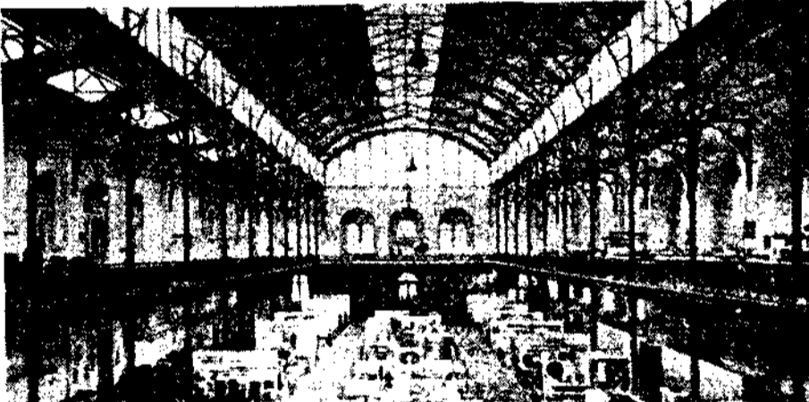
Η πρόσοψη αυτή, σ' έκπολιτισμένο ρυθμό 'Αναγεννησούς, έγινε γιά να κρύβη την κλοσότητα αυτή σίτουσα, επειδή ή κατασκευή της (πρώτο στέρο και γυαλί) έχει στοιχεία νέα και άπειτασια γιά να έμφανισθή αρχιτεκτονικά άπλήθη καλλιτεχνική δημογραφία επί νέων βάσεων.
