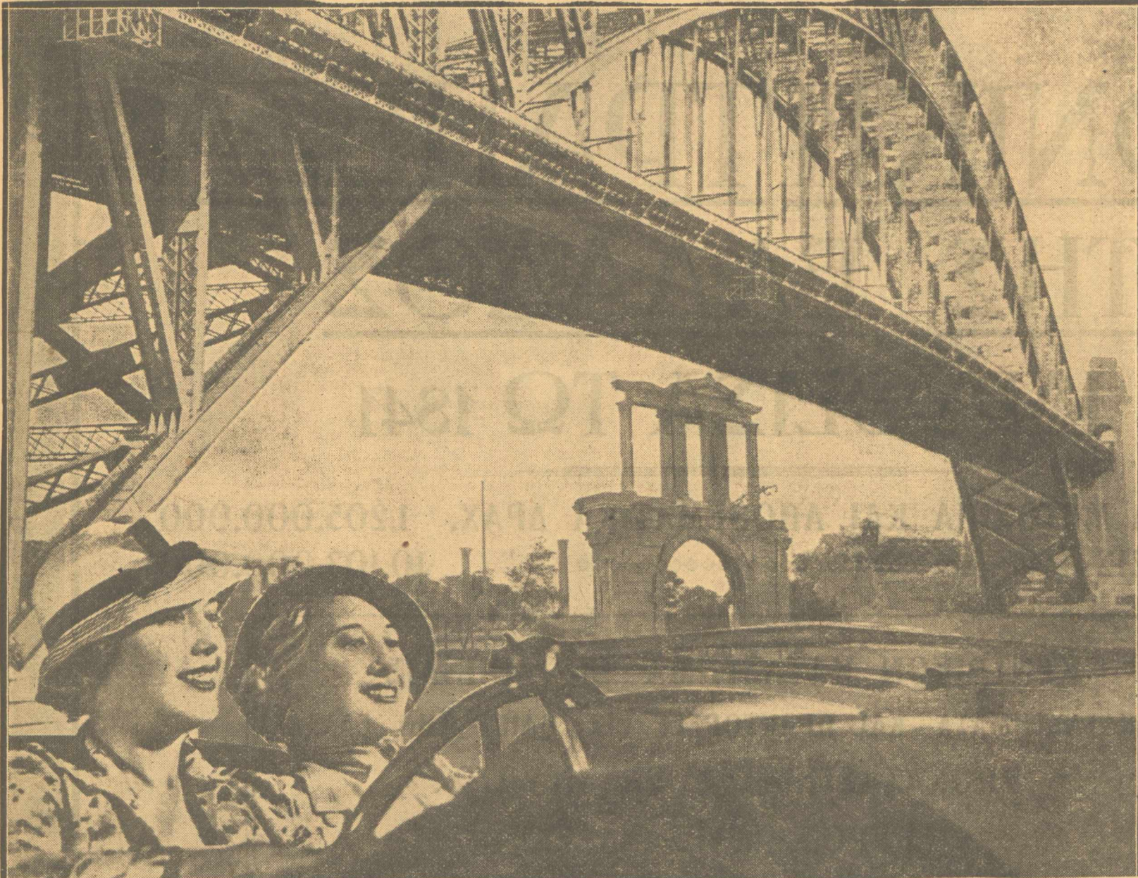
Χθές παρεδόθη εις την κυκλοφορίαν ο περιφερειακός σιδηρόδρομος των 'Αθηνών.-Μία άποψίς του πρό των στηλών του 'Ολυμπίου Διός.
