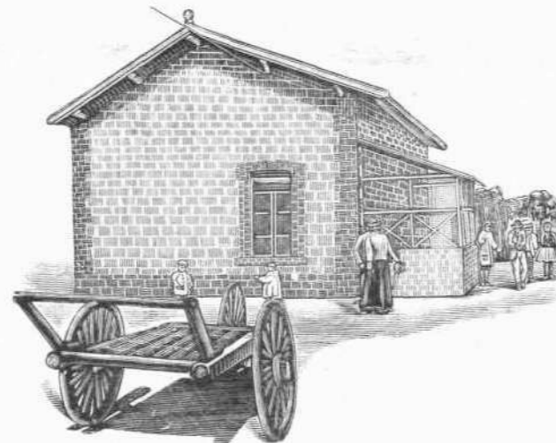
ΕΙΚ. 10. Σταθμὸς σιδηροδρομοῦ Μεσσολογίου Ἀργινοῦ.
