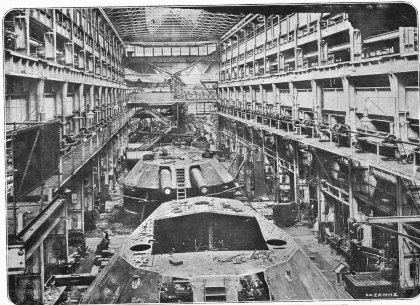
ΜΗΧΑΝΟΥΡΓΕΙΟΝ ΚΑΤΑΣΚΕΥΗΣ ΠΥΡΓΩΝ, ΕΙΣ ΤΩΝ ΟΠΟΙΩΝ ΦΕΡΕΙ ΠΥΡΒΟΛΑ ΤΩΝ 34 ΥΦΕΚ.
