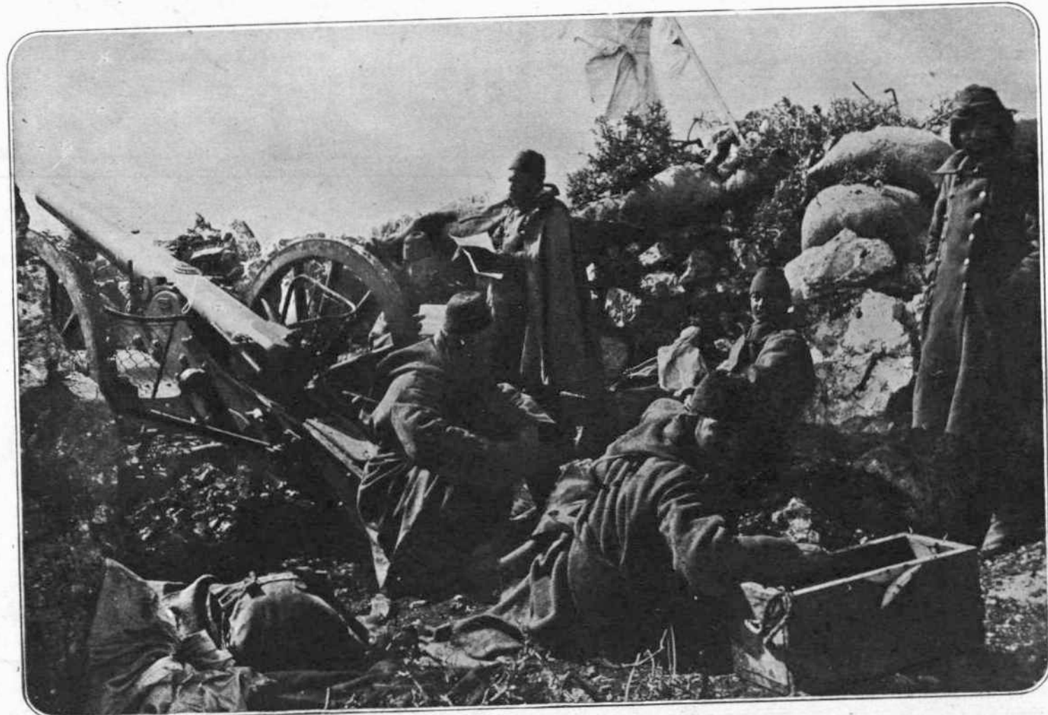
ΜΠΙΖΑΝΙ! — Αὐτὰ εἶναι τὰ φοβερὰ καὶ τρομερὰ ὄχηράματα τοῦ Μπιζανιοῦ. Μόλις παρεδόθη, ἀνήλθεν ἐπ' αὐτοῦ ὁ φωτογράφος κ. Τσαΐτς καὶ ἔλαβε τὴν σπανίαν αὐτὴν φωτογραφίαν.
