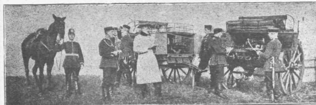
ΣΤΑΘΜΟΣ ΤΗΛΕΓΡΑΦΟΥ.— Τέλειοι οἱ Γερμανοὶ εἰς δια τῶν, κροβλέψαντες διὰ κάθε τι ποῦ θὰ συνέβαιεν εἰς τὴν νίκην τῶν στρατευμάτων τῶν καὶ εἰς τὴν ὑπερίσχιον ἀπέναντι τοῦ ἀντιπάλου τῶν. Ἡ εἰκὼν παριστᾷ σταθμὸν τηλεγραφικῶν εἰς τὸ μέτωπον, τελειοτάτου καὶ ἀκριβεστάτου συστήματος, ὃ ὁποῖος ἠμπορεῖ νὰ στηθῇ καὶ νὰ λυθῇ ἑτοιμος πρὸς μεταφορὰν εἰς διάστημα μόνον 5 λεπτῶν τῆς ὥρας.
