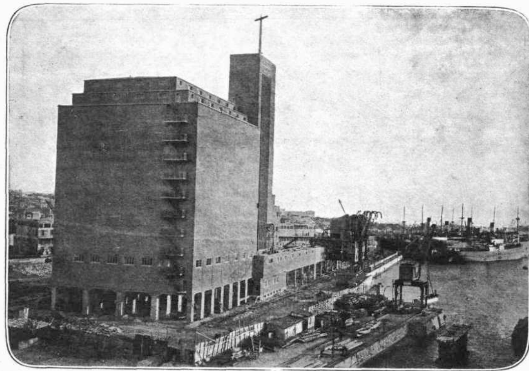
ΤΑ ΤΕΧΝΙΚΑ ΕΡΓΑ ΤΟΥ ΛΙΜΕΝΟΣ ΠΕΙΡΑΙΩΣ. — Γενικὴ ἀπομω τῶν σιταποθηκῶν. THE TECHNICAL WORKS of the harbour of Piraeus. LES TRAVAUX TECHNIQUES du port de Pirée. NEUBAUTEN IM HAFEN von Piräus. — Die neuen Getreidesilo
