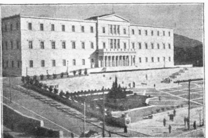
Τά ανάκτορα του Όθωνος, εις τά όποια έστεγάσθη κατά τάς δυσμάς του βίου της ή Βουλή.
