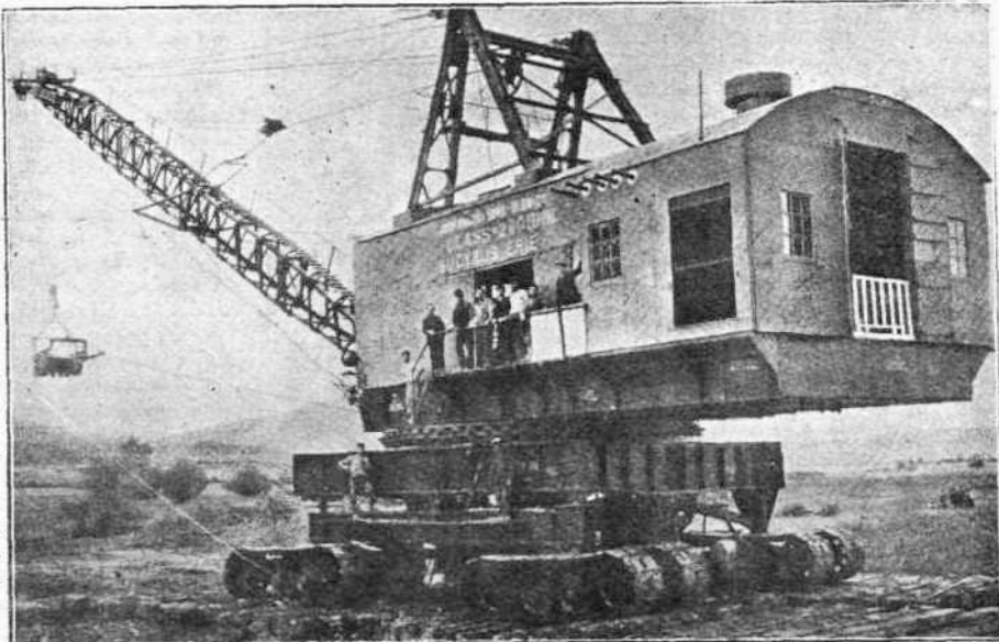
Από τά έργα της Μακεδονίας. Άλλος έκοκατήρ Ντραγκλιν με κάδον 4 κυβικών γουάρδων
