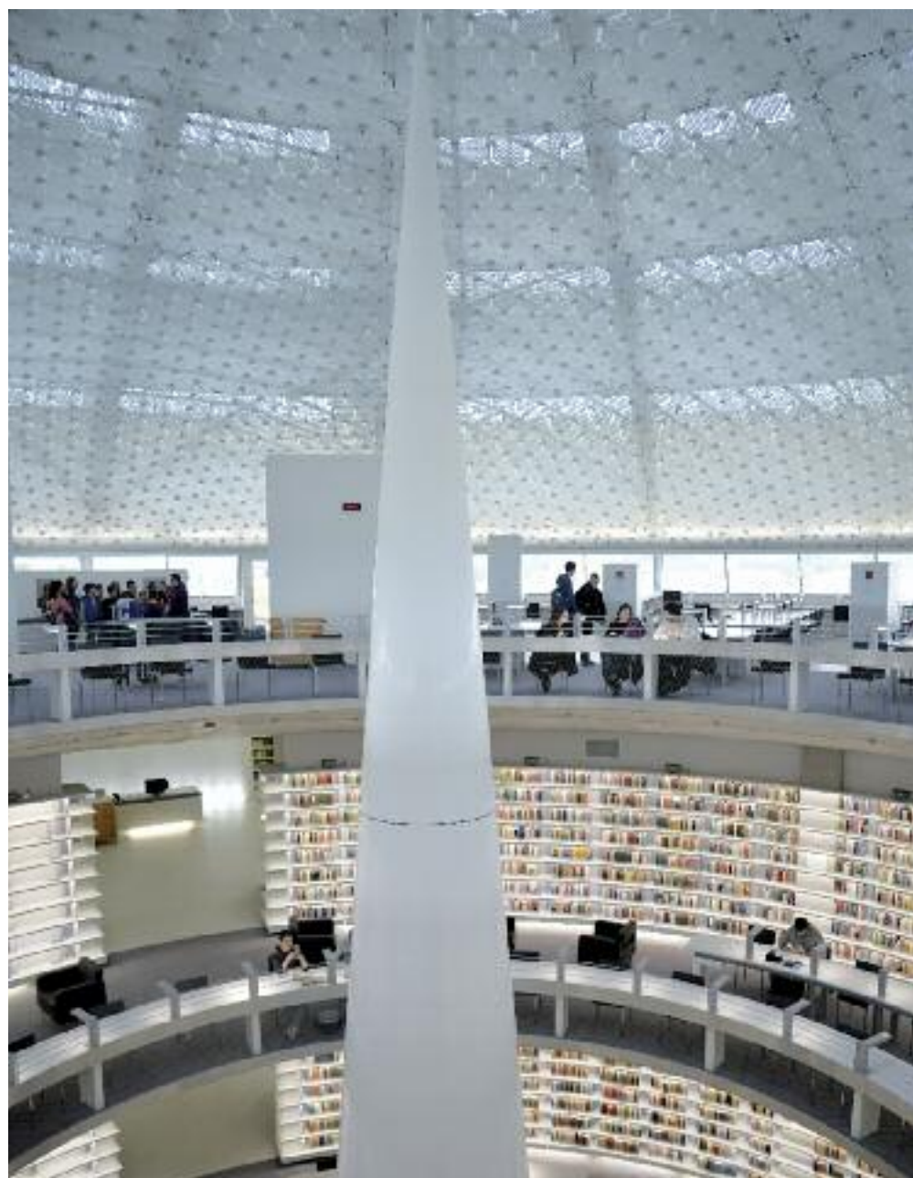
ΕΝΑΣ ΚΩΝΟΣ ΥΨΟΥΣ 24 m, ΒΑΜΜΕΝΟΣ ΜΕ ΣΤΙΛΠΝΗ ΒΑΦΗ, ΣΤΟ ΚΕΝΤΡΟ ΤΟΥ ΑΙΘΡΙΟΥ ΤΗΣ ΒΙΒΛΙΟΘΗΚΗΣ, ΔΙΑΧΕΙΡΙΤΟ ΦΥΣΙΚΟ ΦΩΣ ΑΠΟ ΤΟΝ ΗΛΙΟΣΤΑΤΗ ΣΤΑ ΑΝΑΓΝΩΣΤΗΡΙΑ.
