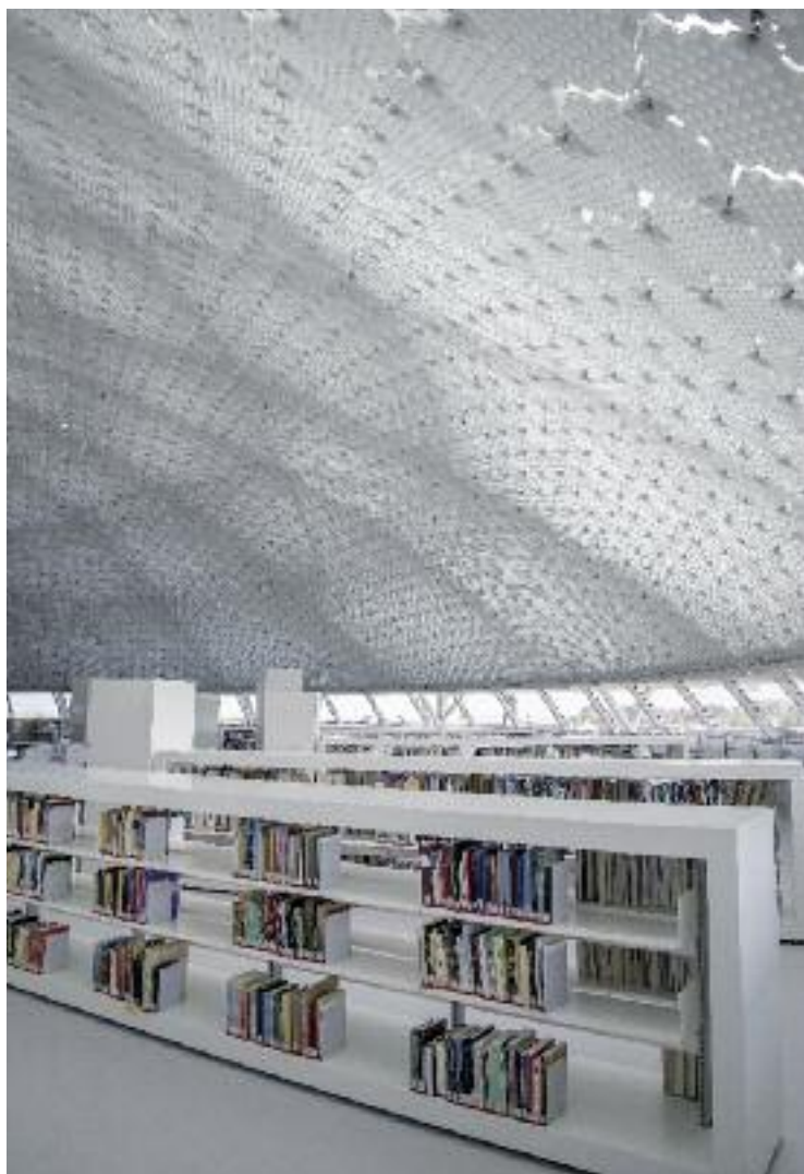
Ο ΤΡΙΤΟΣ ΟΡΟΦΟΣ ΚΑΛΥΠΤΕΤΑΙ ΑΠΟ ΨΕΥΔΟΡΟΦΗ ΑΛΟΥΜΙΝΙΟΥ, ΠΟΥ ΑΠΟΤΕΛΕΙΤΑΙ ΑΠΟ ΚΥΦΕΛΩΤΕΣ ΔΙΑΤΡΗΤΕΣ ΕΞΑΓΩΝΙΚΕΣ ΠΛΑΚΕΣ.
