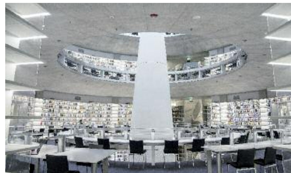
ΟΙ ΟΡΟΦΕΣ ΤΗΣ ΒΙΒΛΙΟΘΗΚΗΣ ΕΙΝΑΙ ΑΠΟ ΕΜΦΑΝΕΣ ΟΠΛΙΣΜΕΝΟ ΣΚΥΡΟΔΕΜΑ, ΔΙΑΜΟΡΦΩΜΕΝΟ ΜΕ ΑΚΤΙΝΙΚΗ ΔΙΑΤΑΞΗ ΤΩΝ ΣΥΛΟΓΥΠΩΝ.
