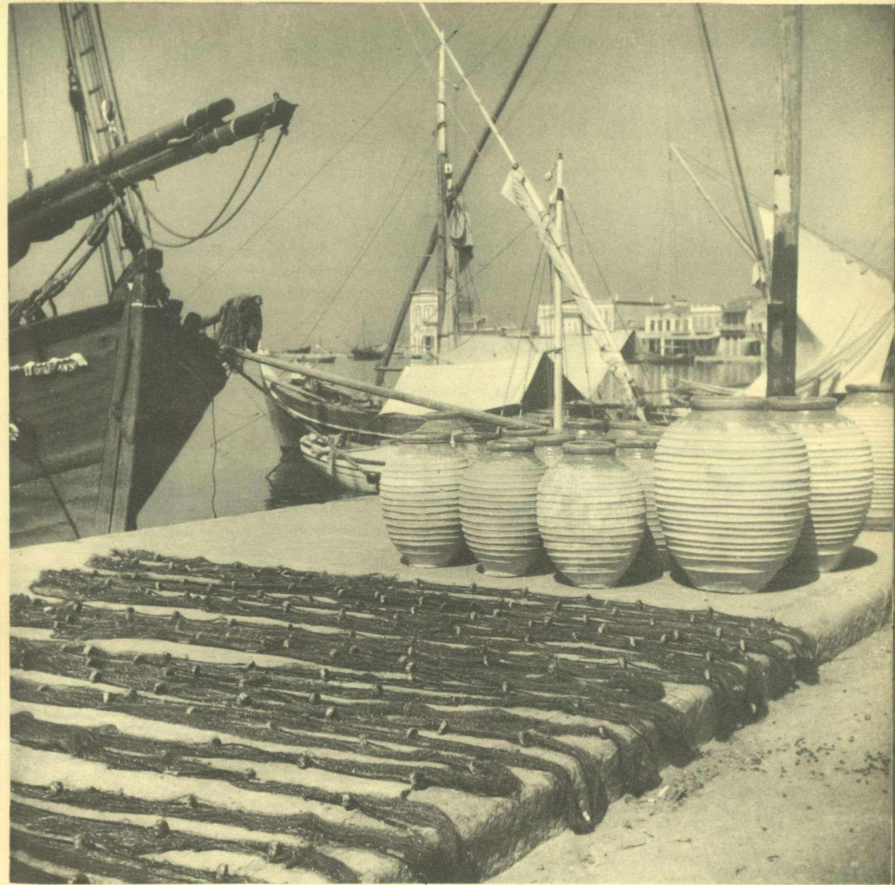
POTERIES PRÊTES POUR LE CHARGEMENT DANS LE PORT D'EGINE
