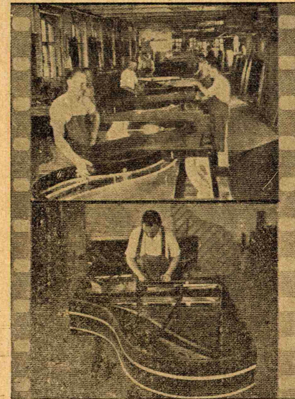
Ἄνω: Εἰς τὸ τμήμα κατασκευῆς «βάσεων ἀντηχήσεως».
