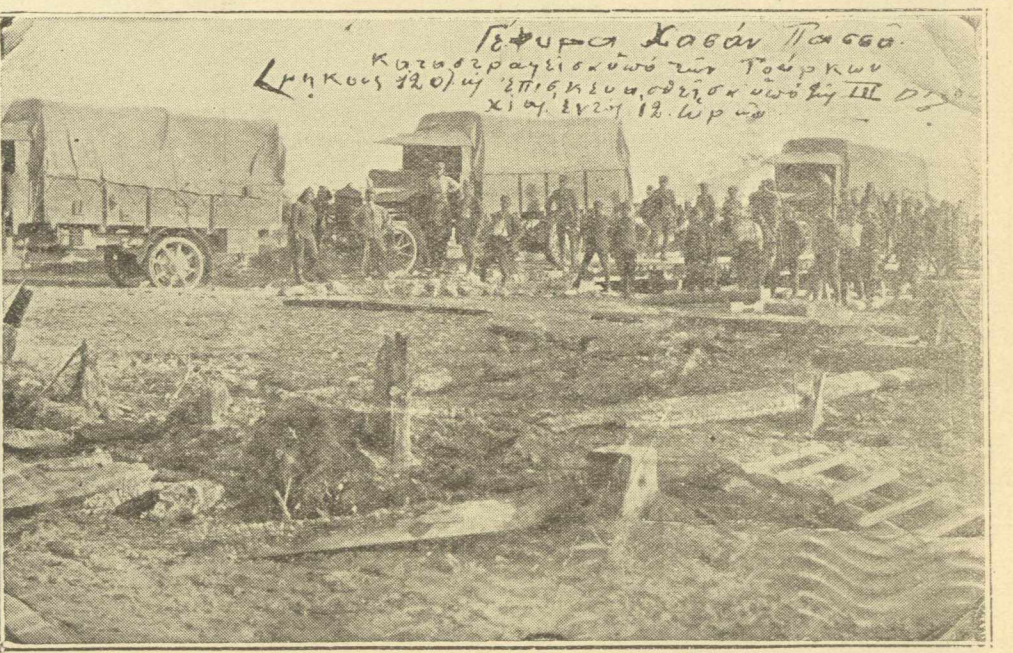
Γέφυρα Χασάν Πασά, έγχευσα μήκος 12) μέτρων. Κατεστράφη υπό των Τούρκων κατά την προέλασιν της 27 Ιουνίου ε. έ. και έπεσεν άσθθη υπό της ΙΙ Διλοχίας του Μηχανικού του Π Λόχου, έντός 12 ώρών από την Διοίκισιν του Λοχαγού κ. Αποκορίτου Εταγγ. και των Άνθυπολοχαγών Ζαγιαριανάκη και Ζήρου.
