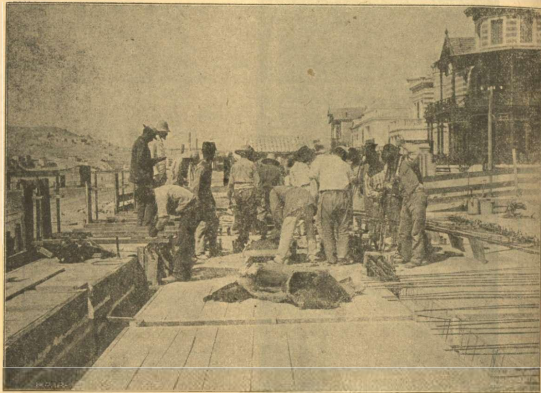
ΓΕΦΥΡΑ ΤΡΙΤΟΞΟΣ ΒΗΗ ΤΟΥ ΚΗΦΙΣΣΟΥ ἐν Νέῳ Φαλήρῳ [Κατὰ τὸ σύστημα Hennebique].
