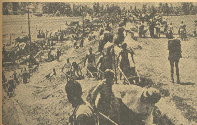
Στὴ Γαλλία: Ὅμαδες ξένων φοιτητῶν ἐργάζονται γιὰ τὴν κατασκευὴ ἑνὸς δρόμου.
