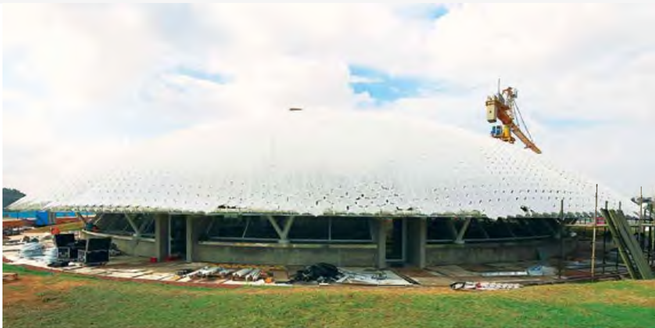
Ο ΘΟΛΟΣ ΤΗΣ ΒΙΒΛΙΟΘΗΚΗΣ ΛΙΓΟ ΠΡΙΝ ΤΗΝ ΟΛΟΚΛΗΡΩΣΗ ΤΟΥ.
