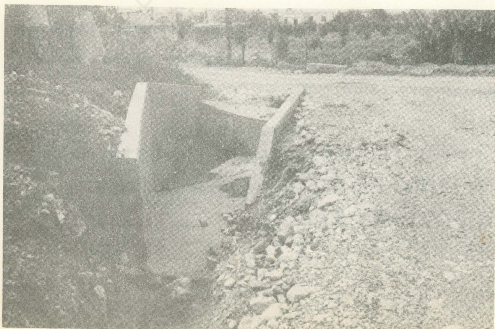
Οχετός για απο- χέτευση των νερών που κατασκευάστη- κε μέσα στα πλαί- σια του αγροτικού οδικού δικτύου Κισσόνεργα/2.
